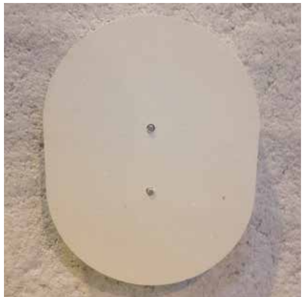
6 - Utiliser l'isolant comme gabarit en le posant sur la trappe de visite
